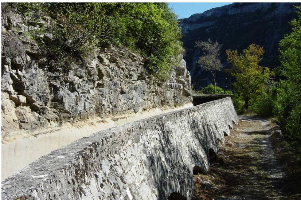
Nous longeons le canal bétonné, de la prise d'eau dans la Vis, long de 12km. Réalisé au début du 20<sup>ème</sup> siècle, il conduit les eaux de la Vis à l'usine hydroélectrique de Madières. Une chute de 112 mètres alimente les turbines
